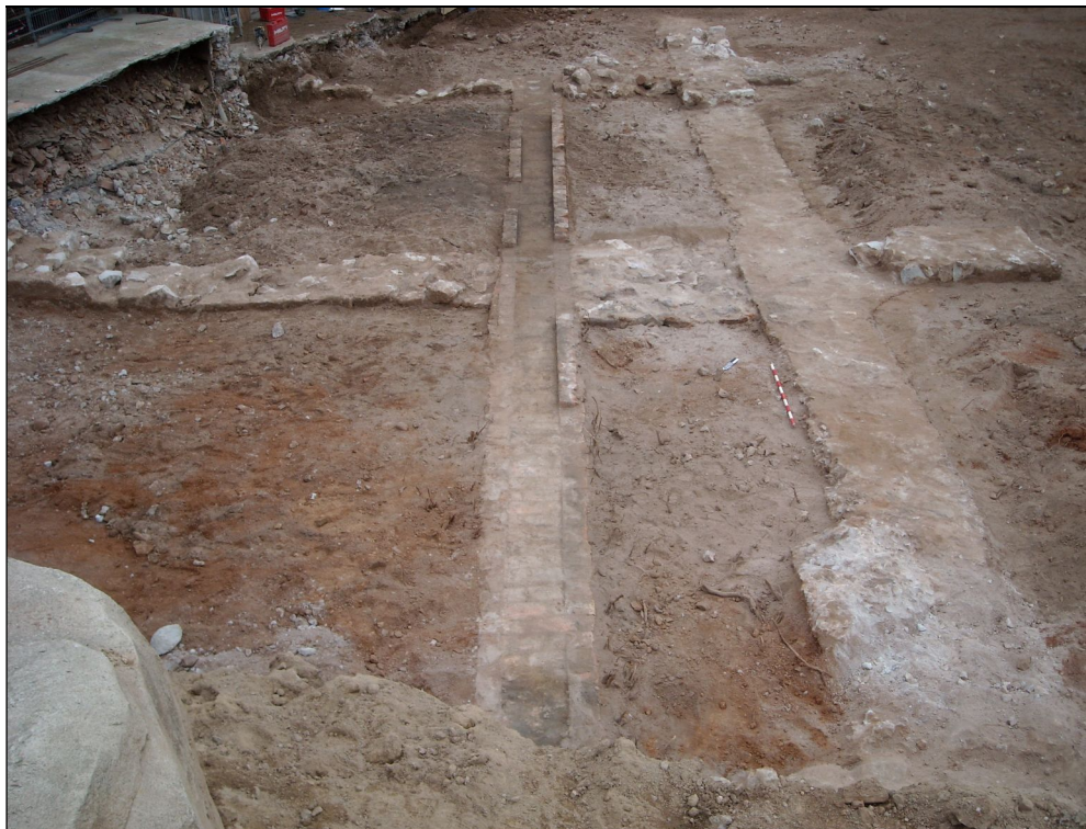
Vista de les estructures documentades del Palau de la Indústria durant el rebaix nocturn
