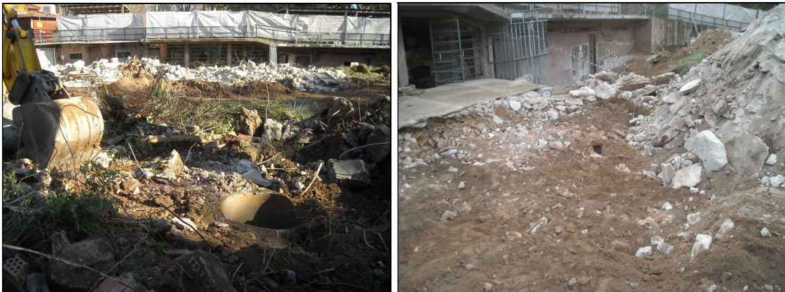
Foto 1: Detall d'un registre de formigó i el mur de pedra picat al fons. Foto 2. Detall de claveguera i de la runa sota l'accés la quadra dels hipopòtams.
