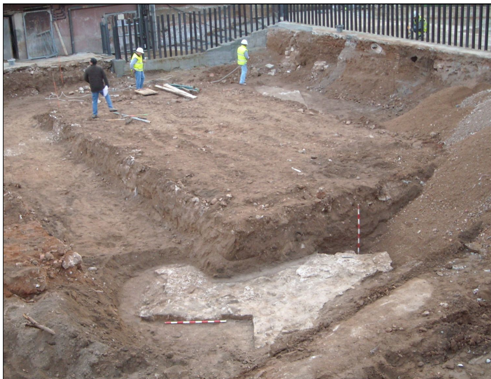
Vista general del solar amb els dos punts on es detecta el mur del baluard de Sant Fernando .
