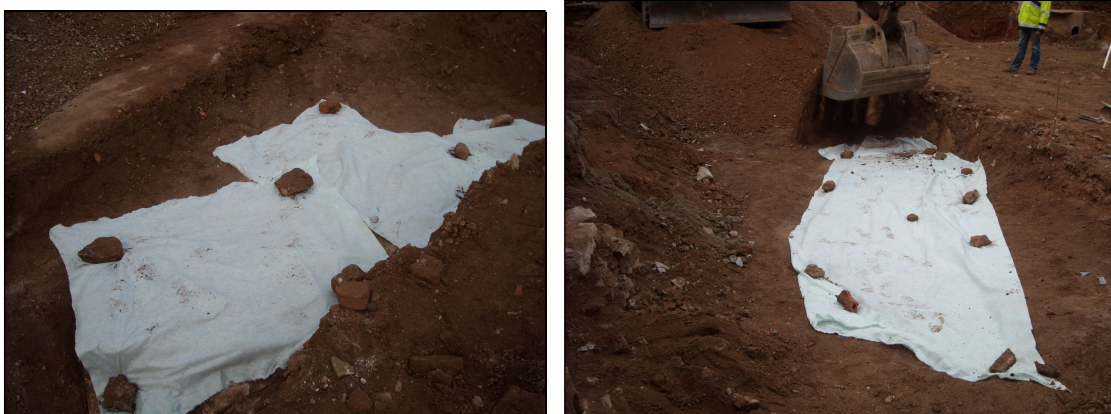
Vista general dels dos trams del coronament del mur UE 119 de la Ciutadella Borbònica amb el geotèxtil
