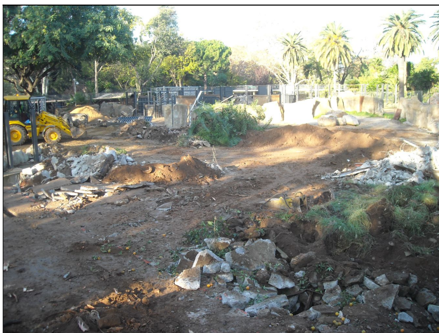
Vista general de les instal·lacions dels damelisc amb part dels murs picats i amb l'elevació nord parcialment rebaixada.
